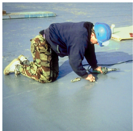
Fig.2: Controle van de lasnaden.
